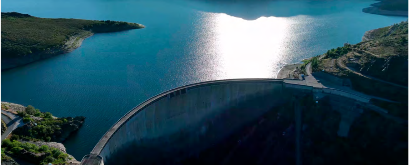
Central hidroeléctrica de Conso, Galicia, España
