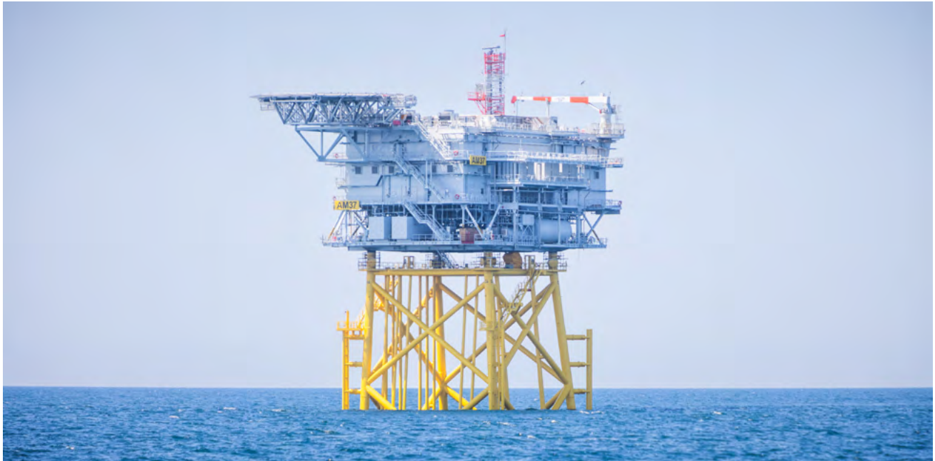
Parque eólico marino de Vineyard Wind - EE.UU.
